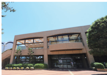
豊橋市総合体育館
